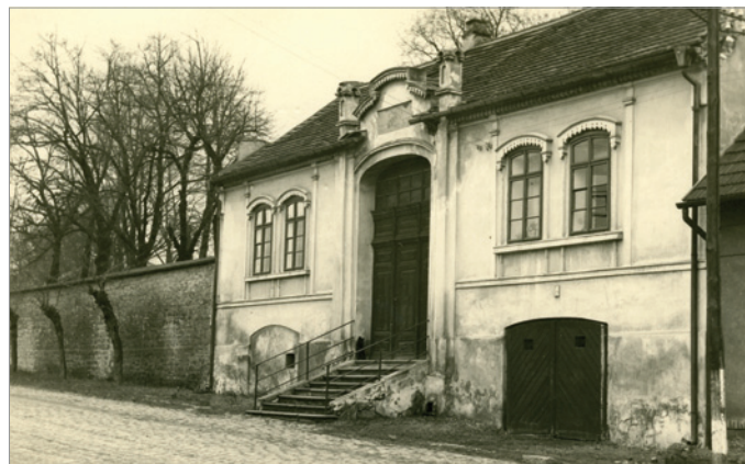
Obřadní síň s vozovnou z r. 1848, 40. léta 20. stol. (Archiv ŽMP, Dokumentace Brandýs n. L.)
